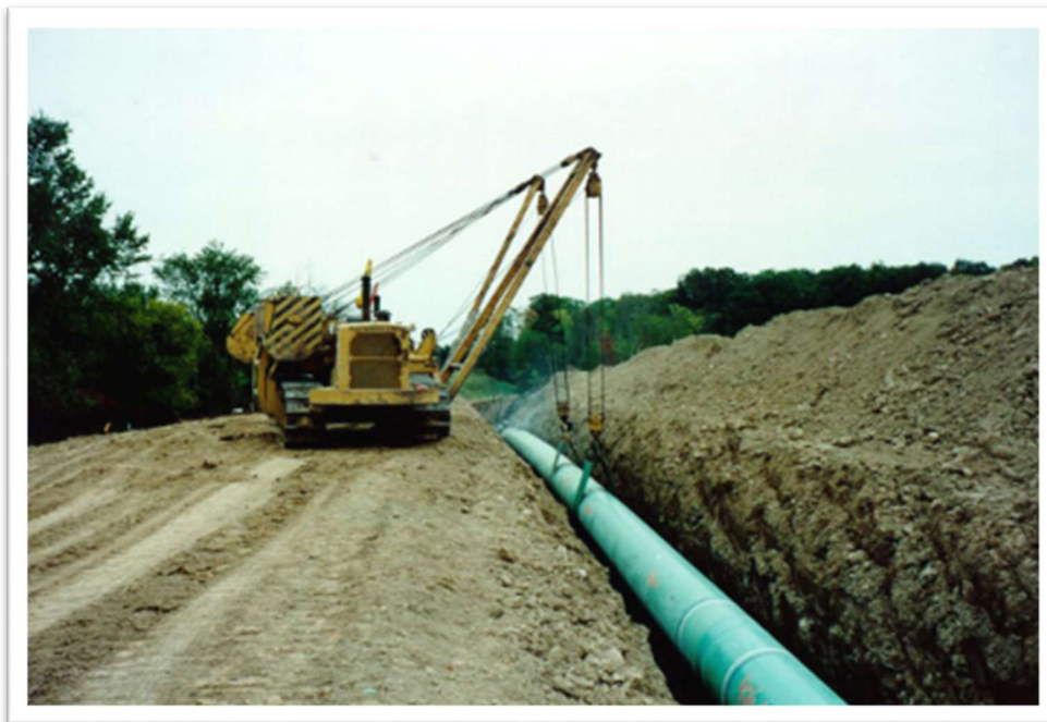
Figura 2.2.4.2.-2 Prezentare a modul de lansare a unei conductei de transport gaze naturale în șanț
