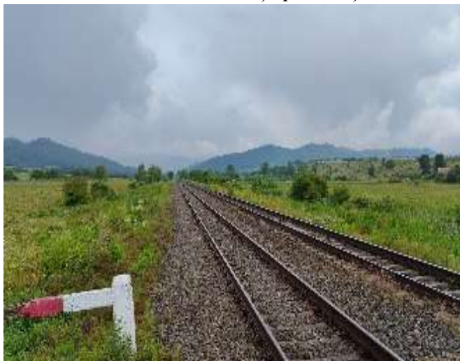
Foto2: Zona subtraversare CF300 și drum E60 km 0,1 - 0,3 UAT Huedin, județul Cluj
