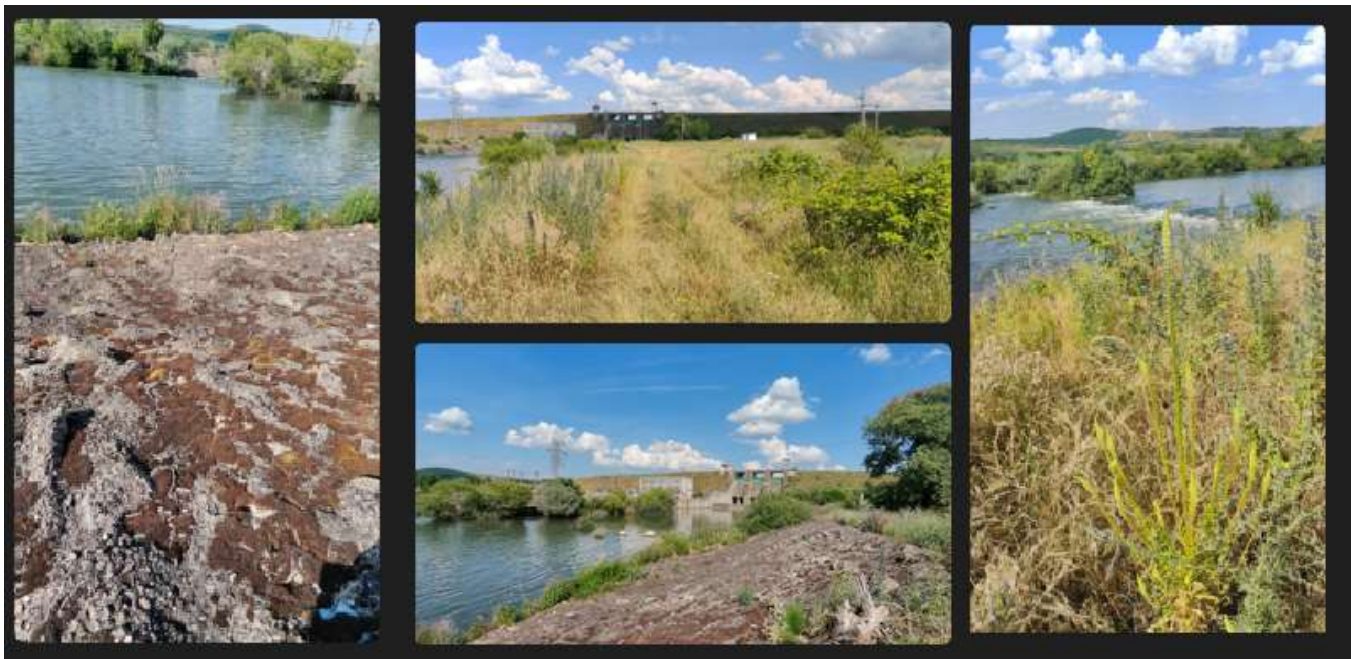
Figura 5.2-6 Aspecte amplasament zonă traversare Crisul Repede (Barajul Lugașu) sit ROSAC0050
