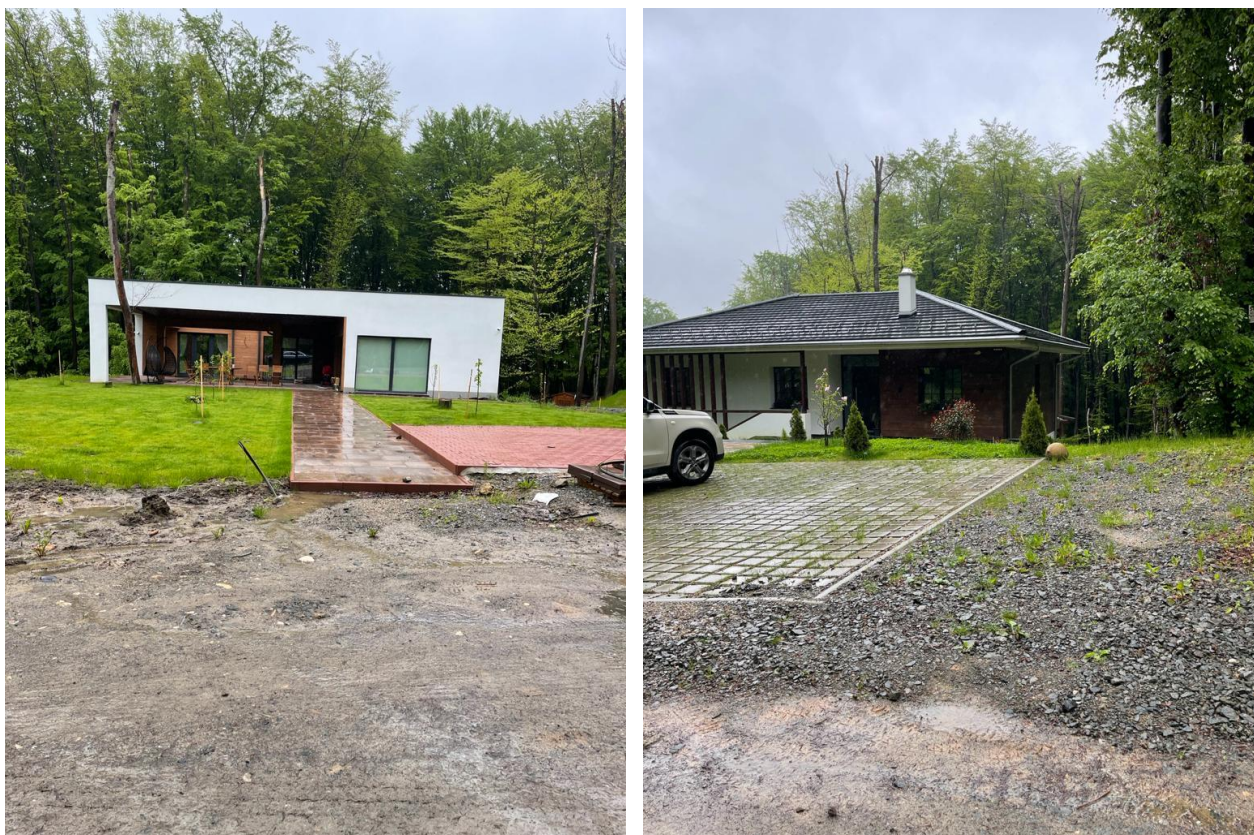
Fig.2-3.Construcții rezidențiale în zona amplasamentului
